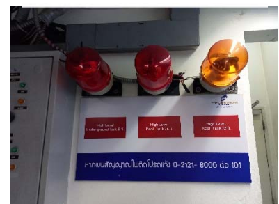
สัญญาณเตือนปริมาณน้ำถึงขีดต่ำสุด
