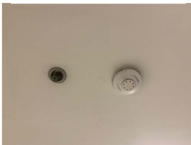
Sprinkler Fire และ Smoke Detector
