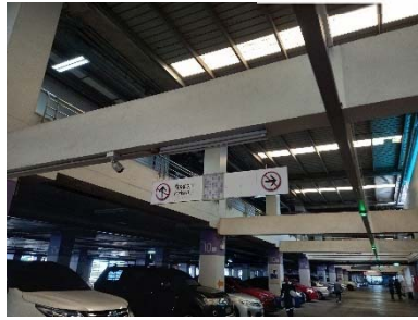
สัญญาณไฟแสดงตำแหน่งที่จอดรถว่าง
